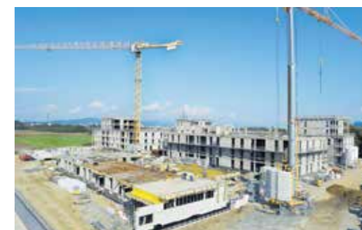
Gerade im Entstehen: die neugebaute Wohnanlage in Viktring KÄRNTNER HEIM-MAT, FOTOLIA
