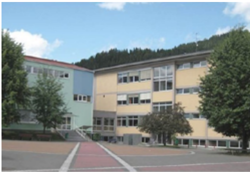
NMS Neumarkt vor der Sanierung
